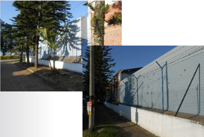
Figura 4: Sistema de barrera acústica y bodega en mampostería CEDI – Fusagasugá
